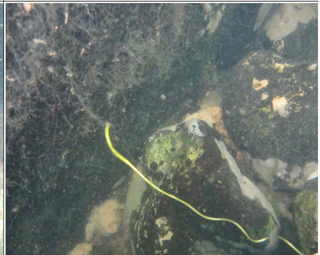
P2상행우측 교각 기초저면, 상태 양호
