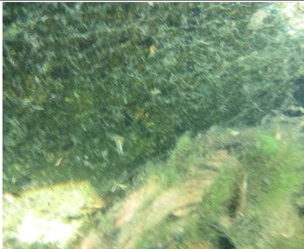
P2하행좌측 교각 기초저면, 상태 양호
