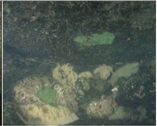
P2상행우측 교각 기초저면, 상태 양호
