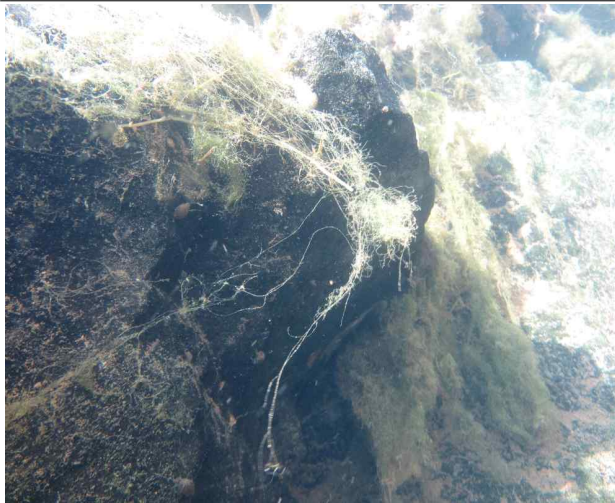
P2하행우측 교각 보호사석, 상태 양호
