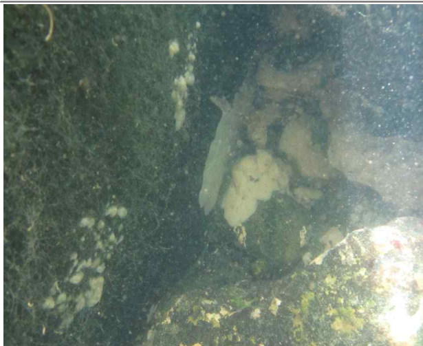
P2상행우측 교각 기초저면, 상태 양호
