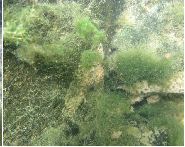
P2하행좌측 교각 기초저면, 상태 양호
