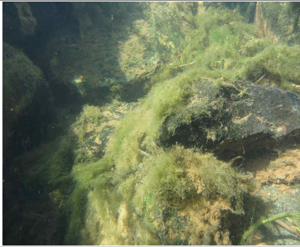
P2하행우측 교각 보호사석, 상태 양호
