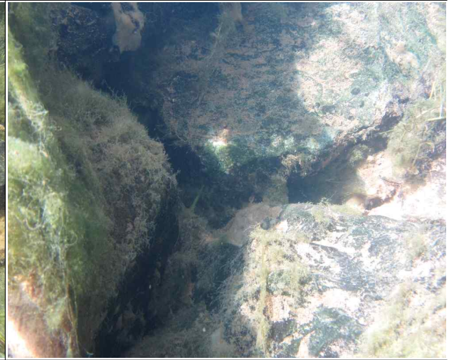
P2하행우측 교각 보호사석, 상태 양호
