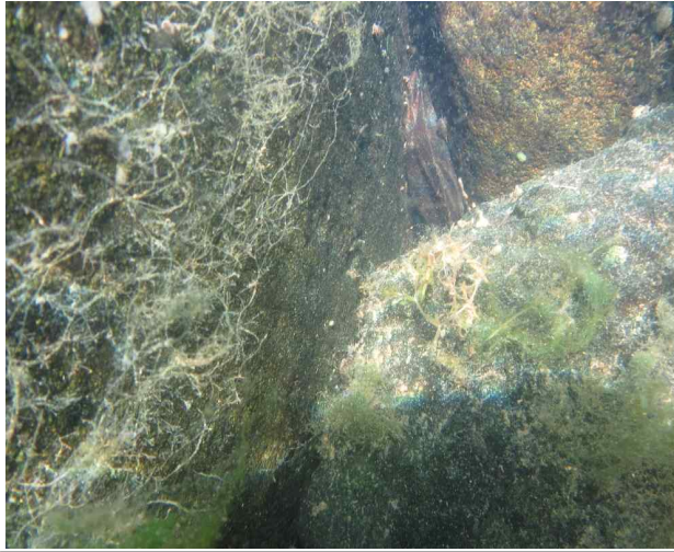
P2하행좌측 교각 기초저면, 상태 양호
