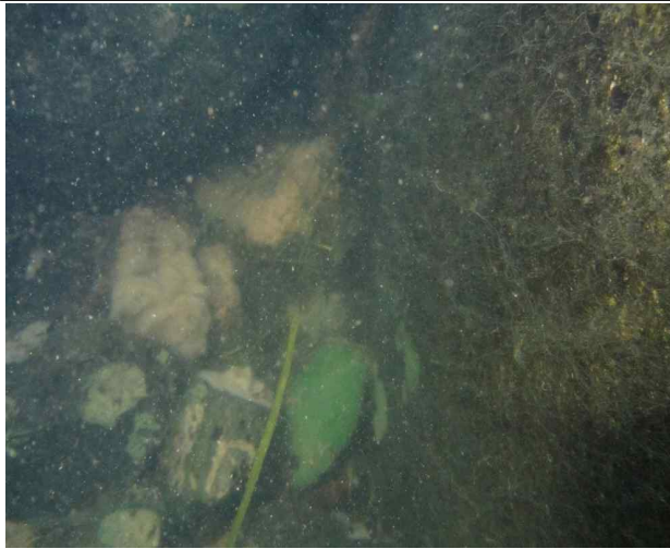
P2상행우측 교각 기초저면, 상태 양호
