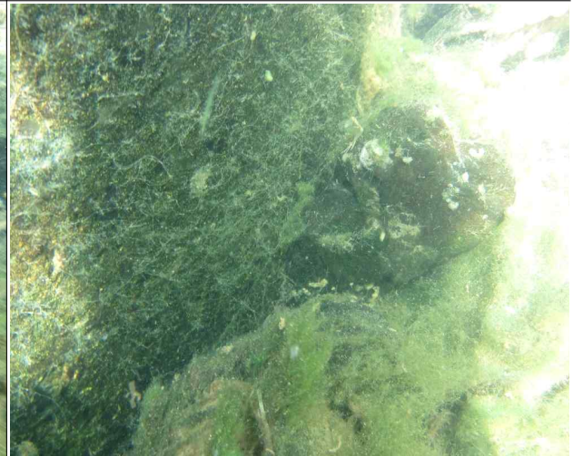
P2하행좌측 교각 기초저면, 상태 양호
