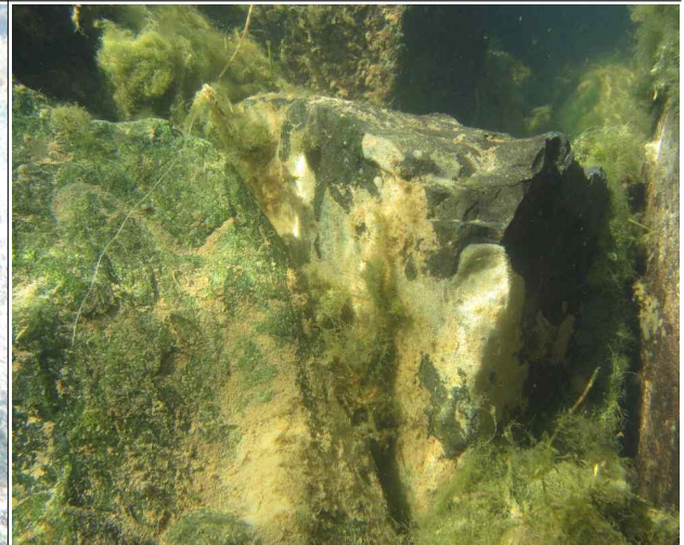
P2하행우측 교각 보호사석, 상태 양호
